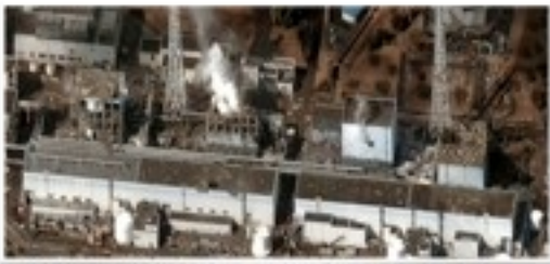
Detallansicht der Reaktorkörbe 1 bis 4 (von rechts nach links) am 16. März 2011 nach mehreren Explosionen und Bränden.
